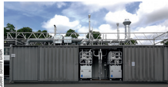
Hochtemperaturelektrolyse-Container der Generation 1.0 (Sunfire-HyLink) am Standort in Dresden
